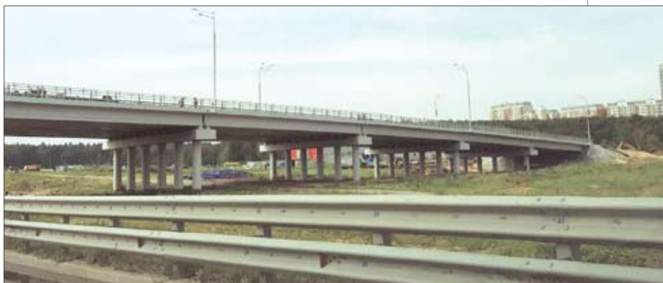
Путепровод над Симферопольским шоссе
